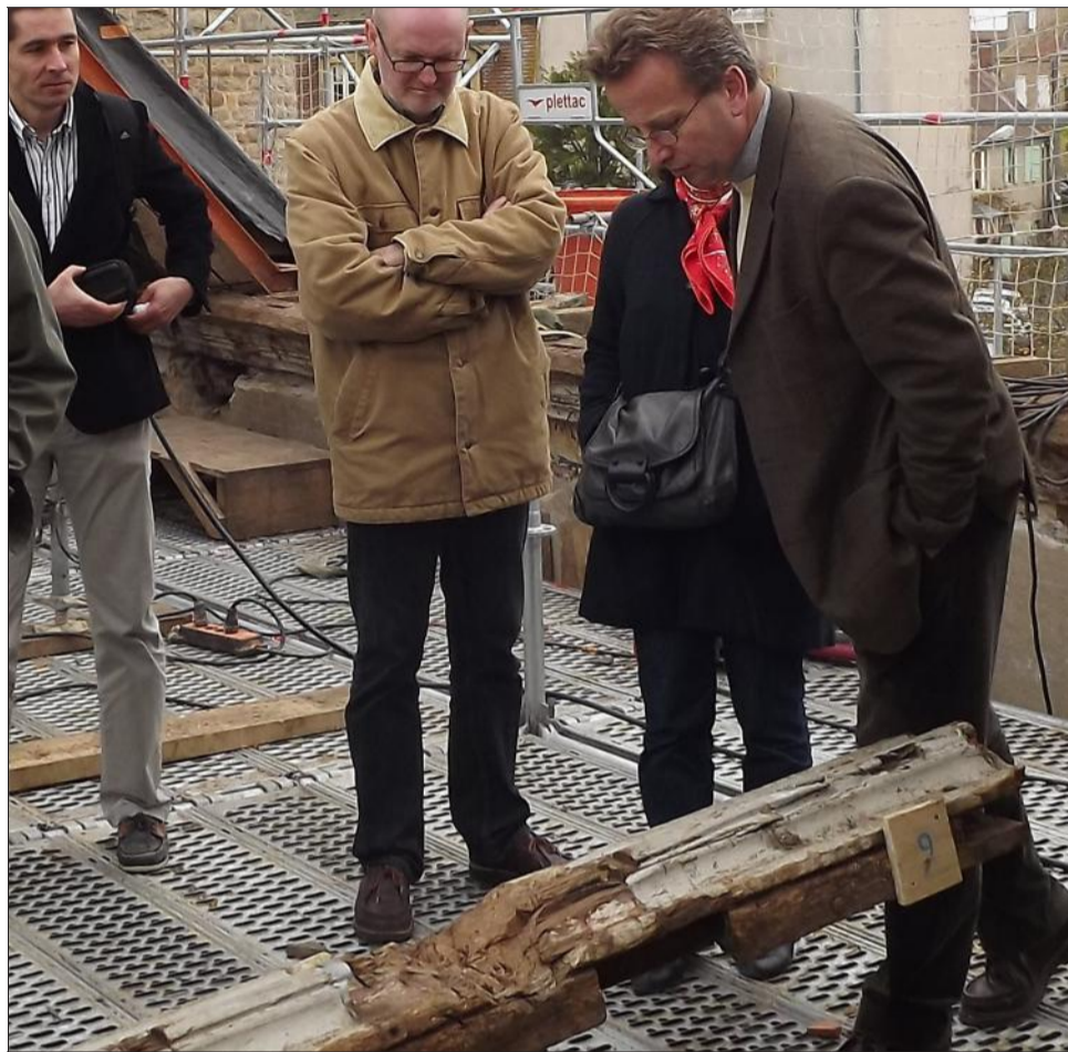
Frédéric Didier au premier plan, inspecte les bois de la charpente de l'église de Perrecy-les-Forges qu'il a fallu entièrement démonter et resserrer, l'édifice menaçait de tomber en ruine. Photo d'archives JSL
